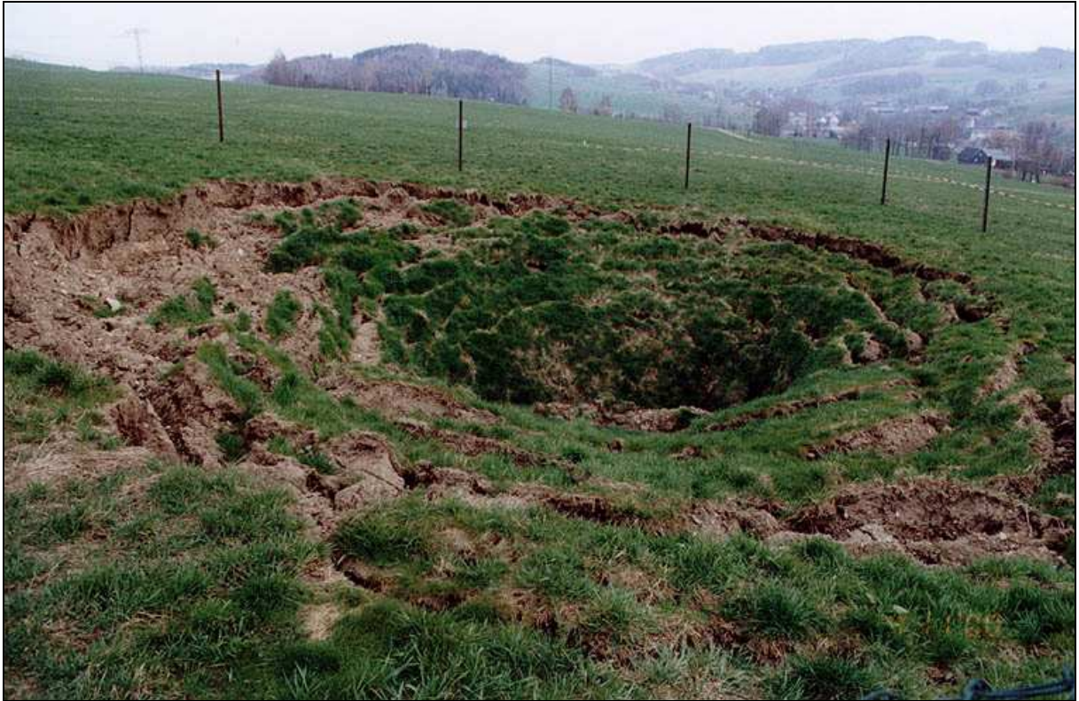
Bild 4: Verbruchtrichter eines Schachtes im Erzgebirge
