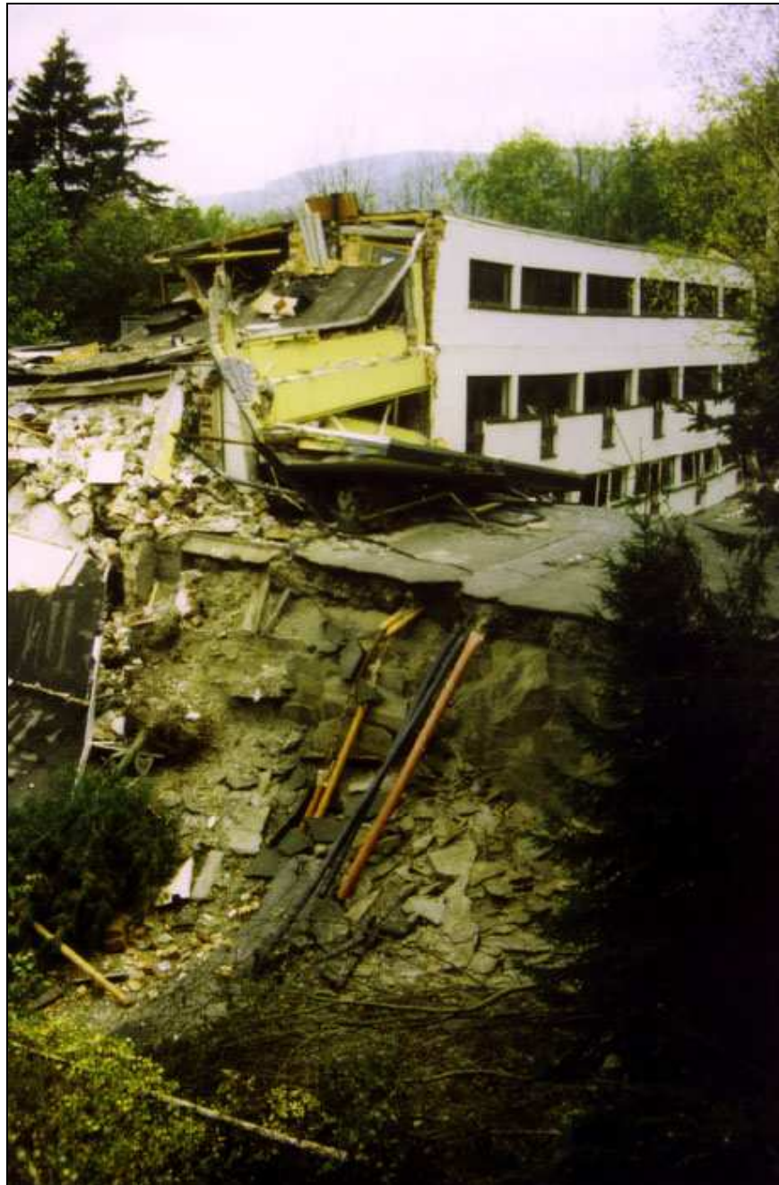
Bild 3: Zerstörter Wohnkomplex durch Verbruch von Abbauen der Fredeburger Dachschieferlagerstätte
