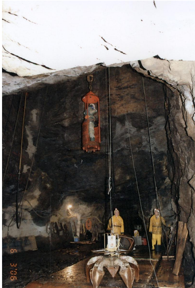
Abb.2 : Freigelegtes Füllort des Schachtes 302 in 107 m Tiefe
