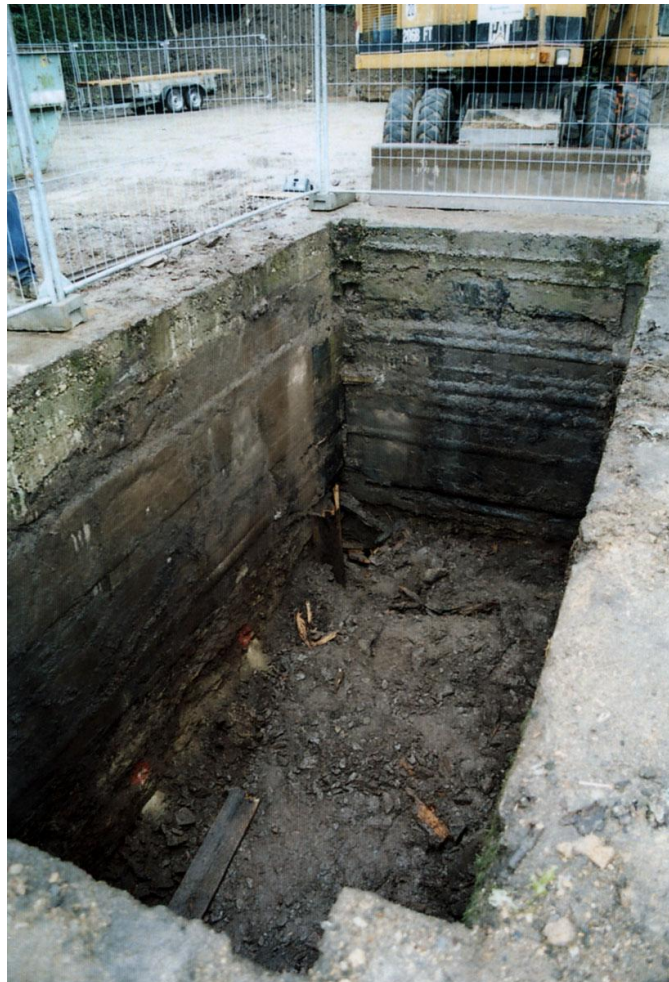
Abb.1 : Freigelegter und gesäuberter Schachtkopf am Beginn der bergmännischen Aufwältigung des Schachtes 302
