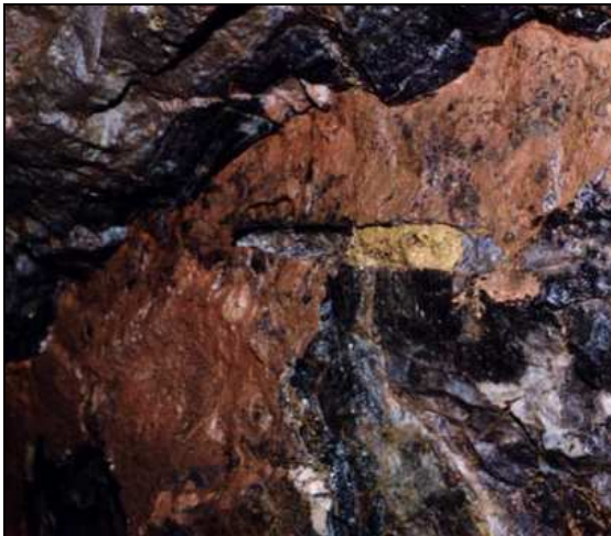
Bild 8: Bohrloch mit Lehmbesatz in der Gangauffüllung (Flussspat) des Trau auf Gott Stehenden (6)
