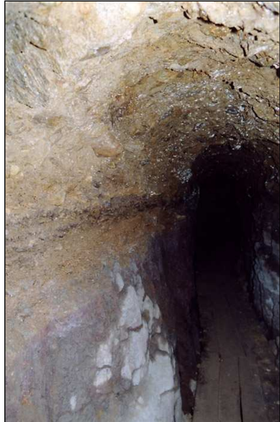
Bild 5: Stollenabschnitt mit einer Firste aus Terrassenschotter des Gimmlitz-Baches
